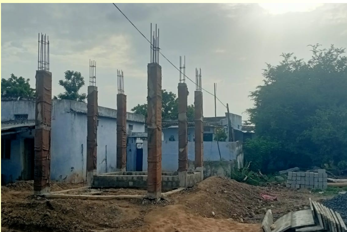
గ్రామంలో నిర్మాణం చేస్తున్న పోచమ్మ గుడి
