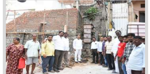
మల్కాజ్గిరి, 20 (పీసీడబ్ల్యూ న్యూస్ ప్రతినిధి): కస్ట్ ఆనంద్ బాగ్ డివిజన్ పరిధిలోని బిజెఆర్ సగర్లో రిటైనింగ్ వాల్ మరియు మెట్ల నిర్మాణ పనులను పోల్స్ షిఫ్టింగ్ ట్రాన్స్ఫార్మర్ షిఫ్టింగ్ పనులను కార్పొరేటర్ వై ప్రేమ్ కుమార్ సంబంధిత సంబంధిత అధికారులతో కలిసి పరిశీలించడం జరిగింది. ఈ కార్యక్రమంలో ఏకా శ్రీకాంత్ ఎలక్ట్రికల్ ఏకా గోపాల్ నాయకులు బాబు సత్యనారాయణ సంపత్ రావు కిషోర్ తదితరులు పాల్గొన్నారు
